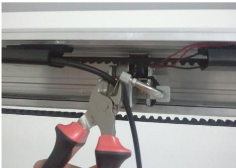
Вставьте изоляционную оболочку через кабельные вводы так, чтобы она прошла до электрозамка. Отрежьте излишки оболочки.
